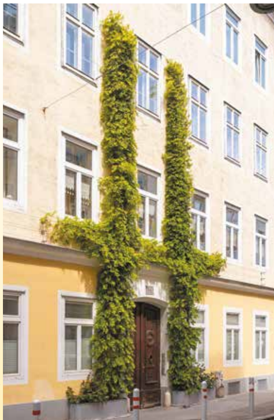
Die positiven kleinklimatischen Auswirkungen von Fassadenbegrünungen sind seit langem bekannt
